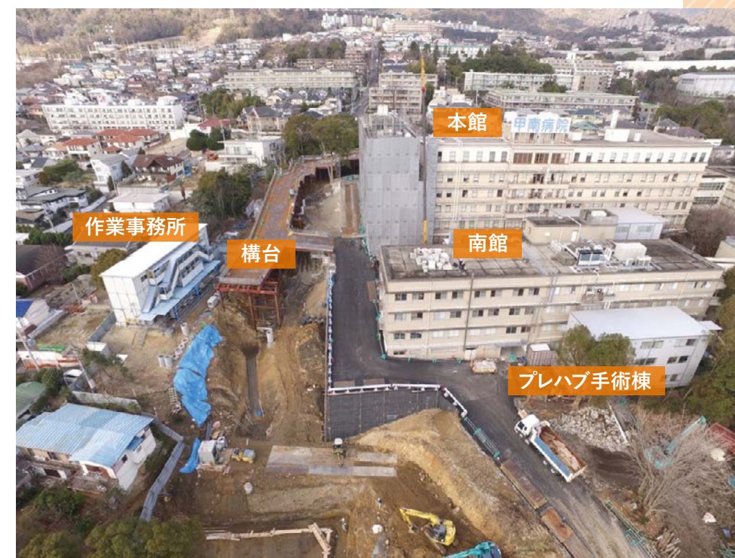
【図2】工事中の現場写真(2017年頃)。 旧病院西側の林や小川を切り開き巨大な構台が南北に架橋。 丘陵地の大病院の建築には相応の道具立てが必要でした。
