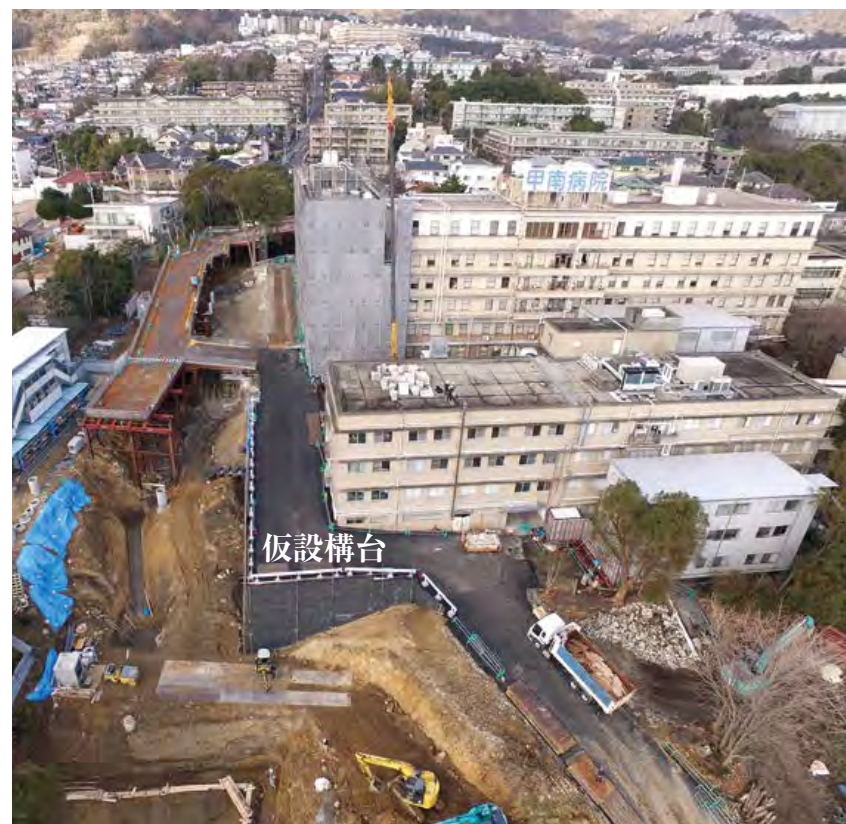
(写真1) 建て替え工事初期：上空から見る旧甲南病院と西側南北に延びる仮設構台／2017年1月
