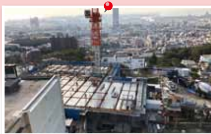
①南館B1階コンクリート打設
