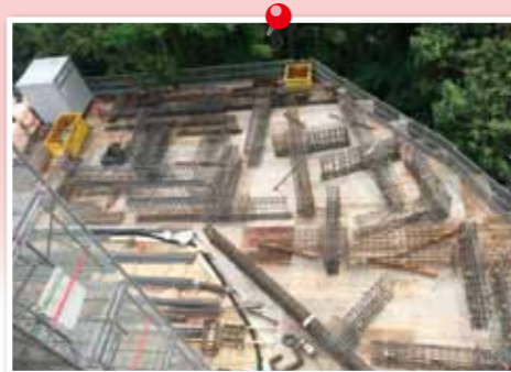
②鉄筋加工ヤード
