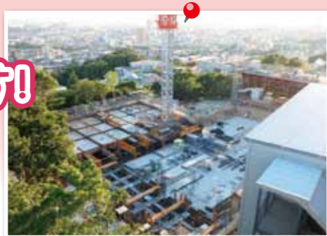
①工事全景
