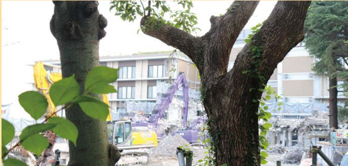
職員専用通路から見る解体の様子
