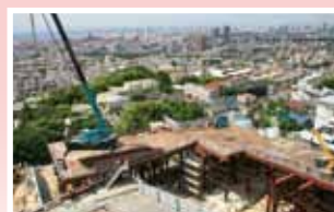
①作業構台
