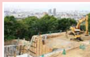
④南館造成工事
